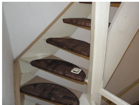
Treppe zum Dachboden
